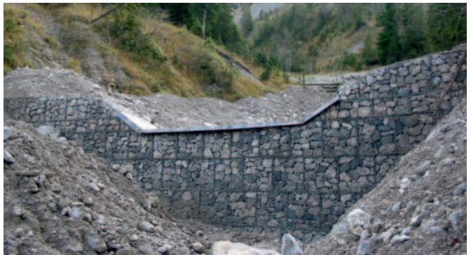
Drahtschotterkastensperre im Lainbachtal
