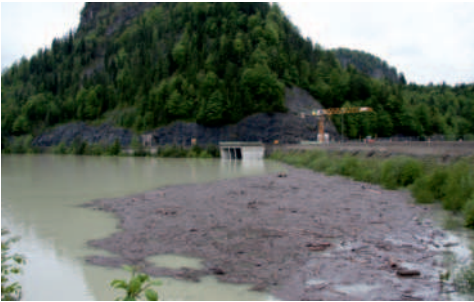
Dammkrone und alte Hochwasserentlastung bei Erreichen des bisher höchsten Speicherwasserstandes am 3.6.2013
