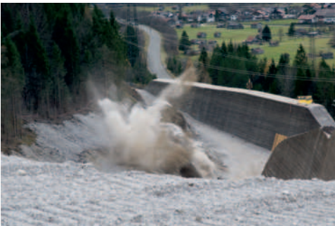
Sprengung von 3.500 m 3 Fels zur Aufweitung des Gerinnes
