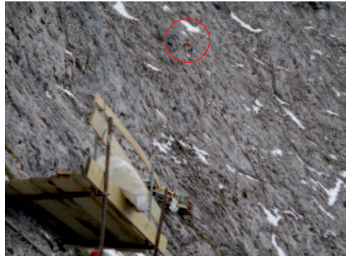
Herstellung der Fundamente für die Sprenganlagen im steilen Fels
