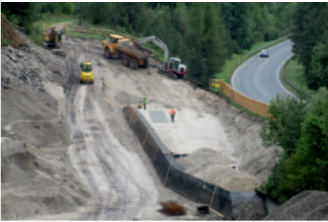
Der Auffangdamm vor der B2 nimmt Gestalt an
