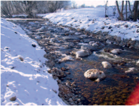
Zur durchgängigen Sohlrampe umgebautes Wehr an der Rott bei Raisting
